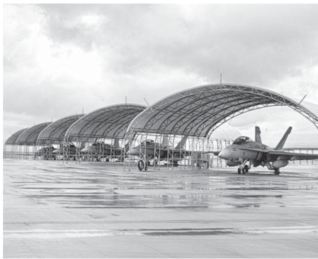
岩国航空基地に新設されたシェルター
