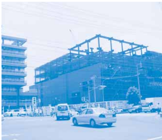
建設中の市役所新庁舎
