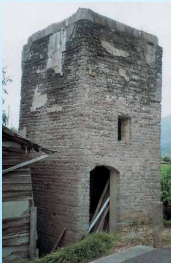
みなみおき ■ 南沖簡易水道塔(由宇町) 昭和17年(1942年)、港地区へ配水するため、井戸を掘ってタンク塔を建造し、私設の簡易水道が設置されました。 この簡易水道は、昭和35年(1960年)に由宇町上水道が設置されるまで使用されていました。
