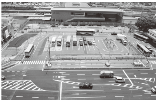
岩国駅西口駅前広場の整備
